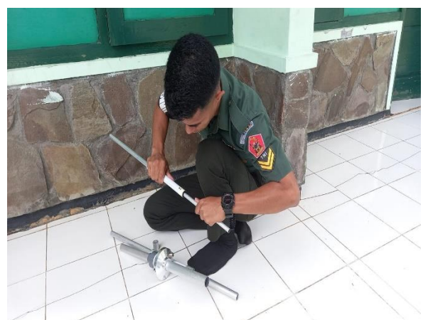
Gambar 7. Penyambungan pipa Pvc
