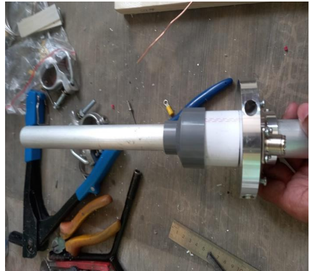
Gambar 6. Pemasangan Bracket antena
